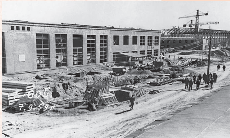
Стройплощадка около третьего производственного здания № 301. 1959 г.
