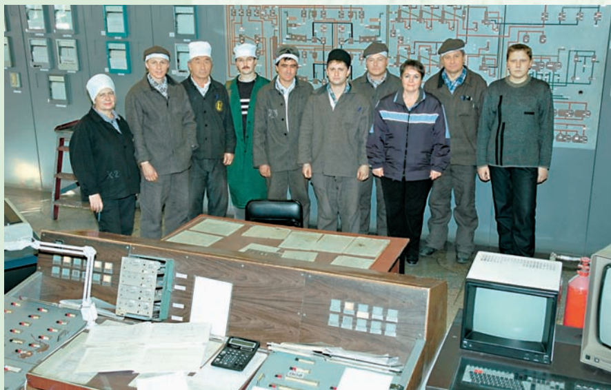
Пульта оператора производства фтористого водорода
