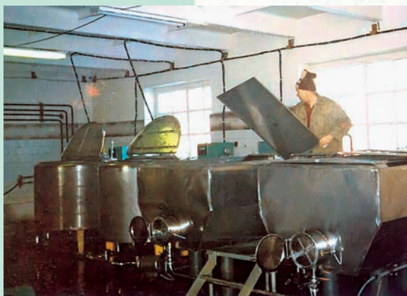
Монтаж творожной ванны
