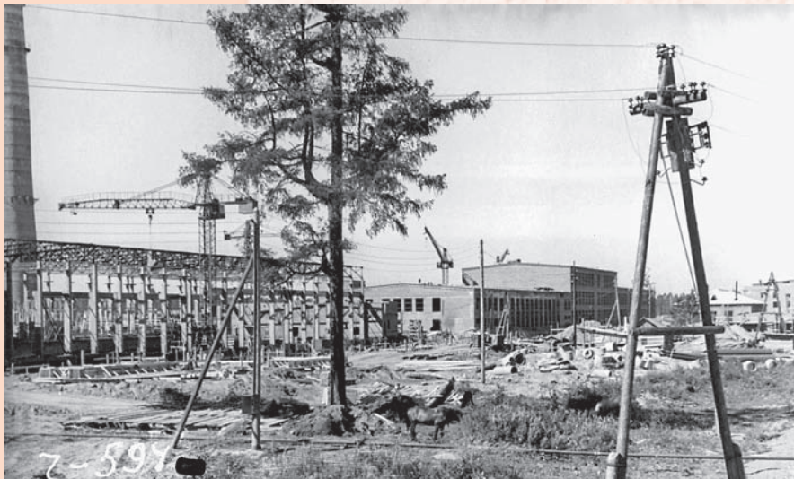
Общий вид строительства зданий № 301 и 303. 1959 г.
