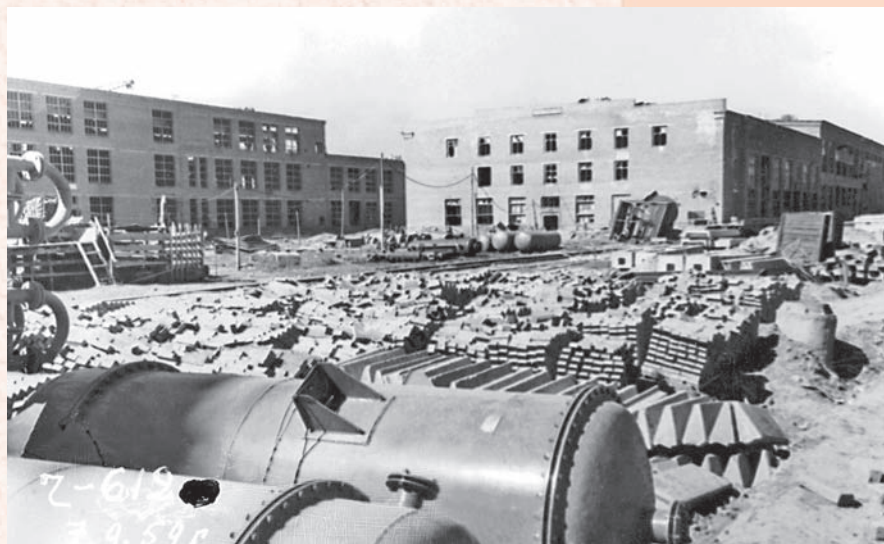
Площадка хранения стройматериалов и оборудования. 1959 г.
