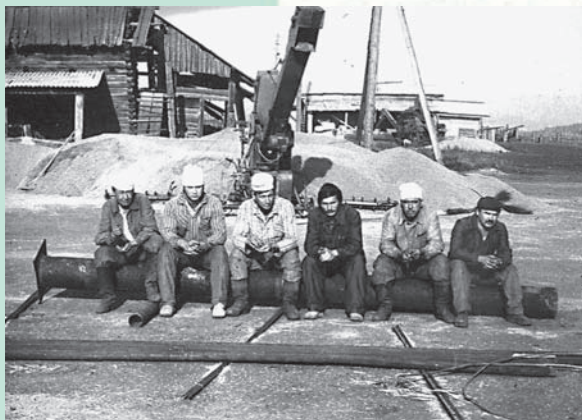
Бригада В.Г. Новохижного. Монтаж зерносушилки в селе Малышовка
