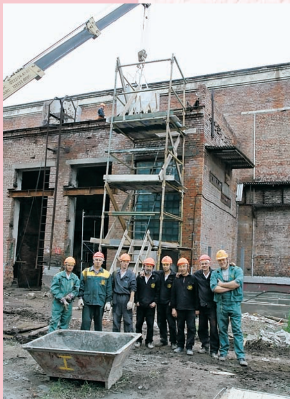
Бригада В.С. Павлова на строительстве участка трифторидазота здания № 301. 2006 г.
